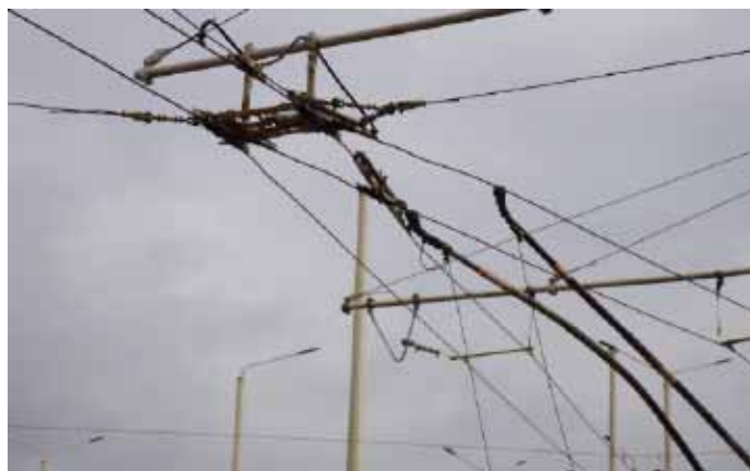
Фигура 5: Тролейбусни проводници и превключватели в лошо състояние в Русе (BG), причинявайки много ниската търговска скорост на превозните средства, получавайки електрически транспорт в неизгодна ситуация
